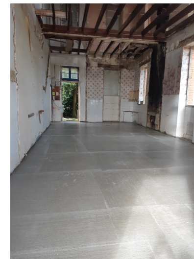
Différentes étapes du chantier : la démolition a permis de mettre à nu le bâtiment, qui s'est avéré sain. Une fois les murs supports créés à la cave, un hourdis a été coulé, la séparation des deux logements a été bâtie puis les escaliers posés.
