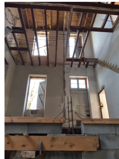
Différentes étapes du chantier : la démolition a permis de mettre à nu le bâtiment, qui s'est avéré sain. Une fois les murs supports créés à la cave, un hourdis a été coulé, la séparation des deux logements a été bâtie puis les escaliers posés.
